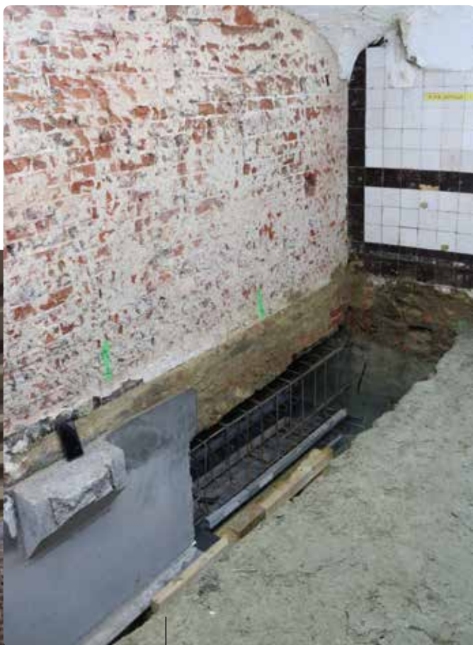
Onderschoeiingen maken het mogelijk om de kelder uit te graven.
