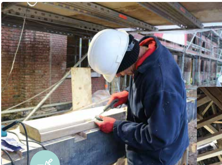
Handwerk voor het bewerken van nieuwe moerbalken.
