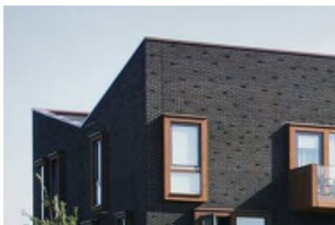
baksteen met houten detaillering
