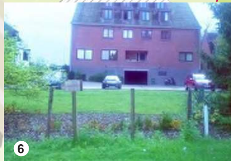
hoogteverschil t.h.v. Kloosterput
