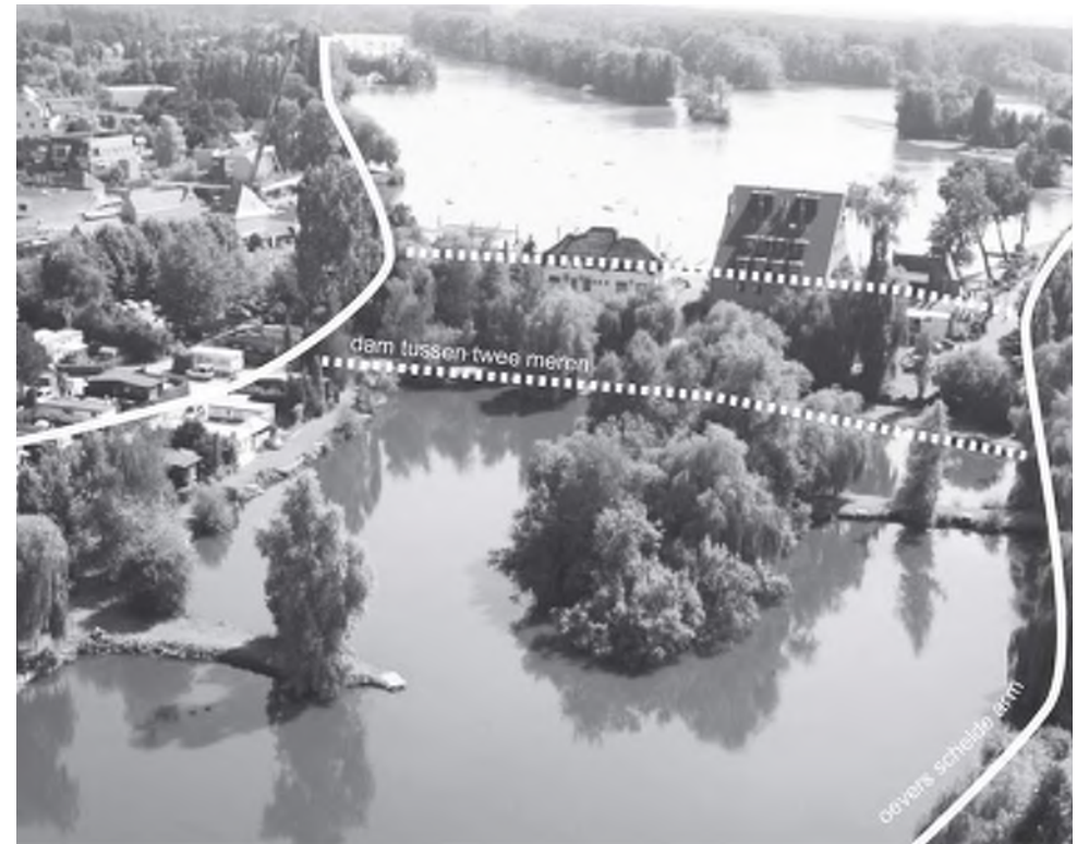
herkenbaar maken dam in Scheldearm
