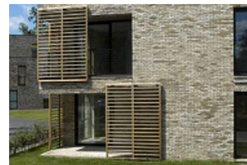
baksteen met houten detaillering
