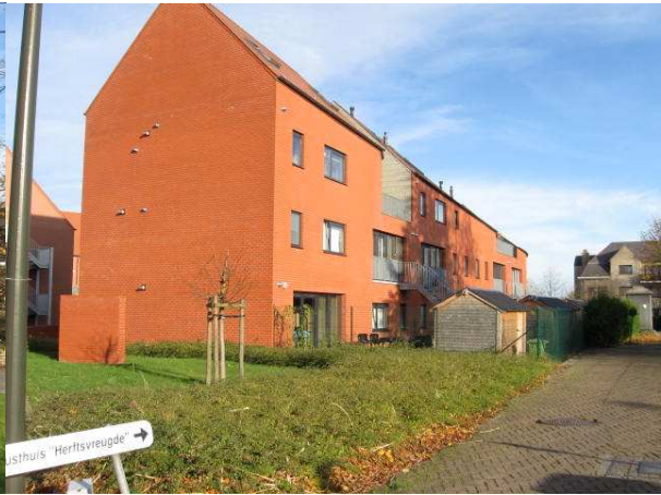
woonproject HIW (toegang rusthuis)
