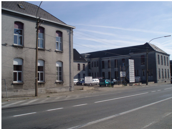
voormalig rusthuis 'Ter Meere' (te slopen)
